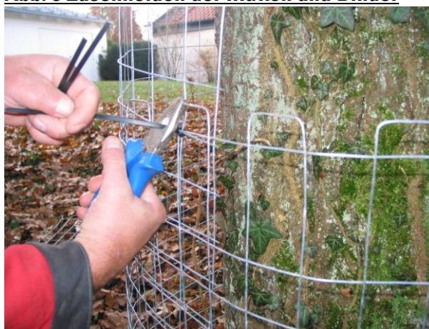
Abb. 6 Zuschneiden der Matten und Binder
